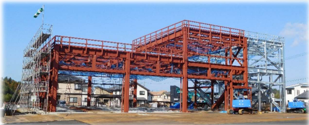
柏崎市内某除雪基地
